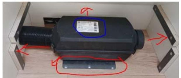
Foto del equipo mostrando el sistema de fijación al suelo, y conforme no toca a ningun material inflamable, y que hay espacio libre por la entrada y salida de aire
