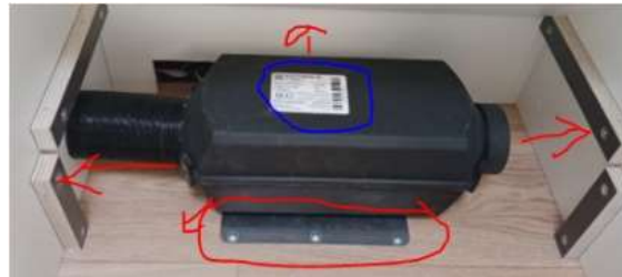
Foto del equipo mostrando el sistema de fijación al suelo + Foto y conforme no toca a ningún material inflamable +Foto conforme hay un espacio suficiente para la entrada y salida de aire
