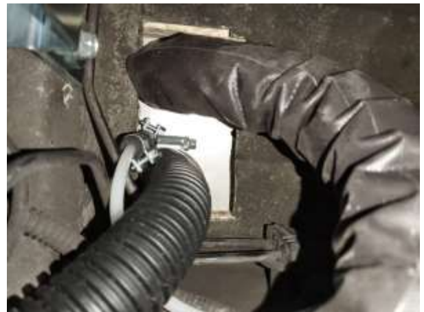
FOTO DE LA SALIDA DE LOS TUBOS
