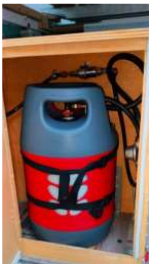
ARMARIO CON BOMBONA+ REGULADOR + VENTILACION INFERIOR
