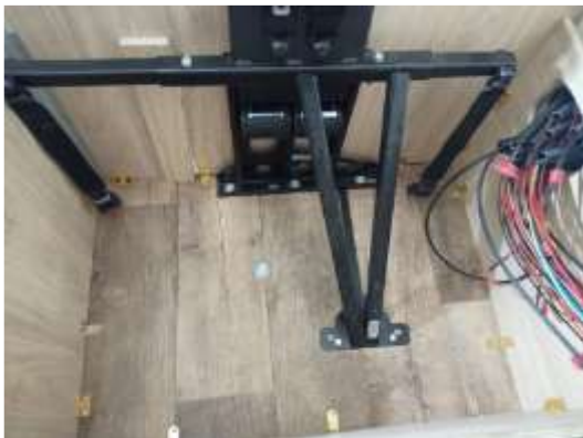
FOTO VIENDO ESTRUCTURA VIENDO LOS ANCLAJES AL SUELO
